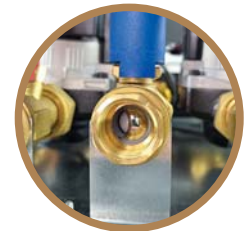
Pozycja „90°” Zawór ZAMKNIĘTY. Brak przepływu.
